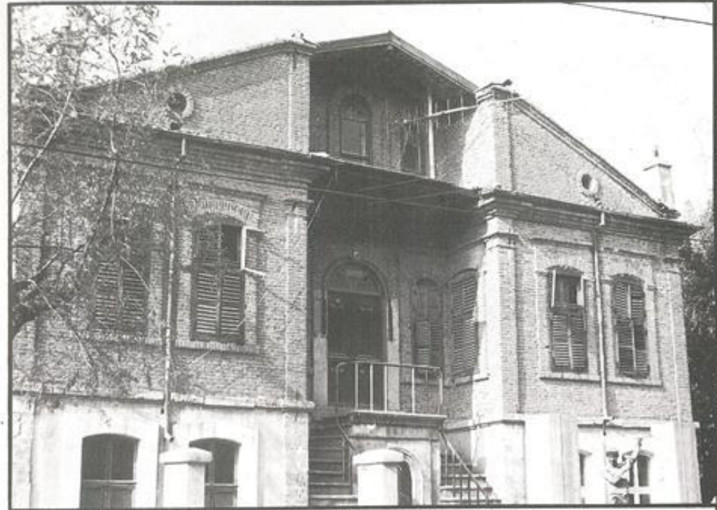
Belediyece düzenlenmekte olan kreş binası Kindergarten that's rearranged by municipality.
